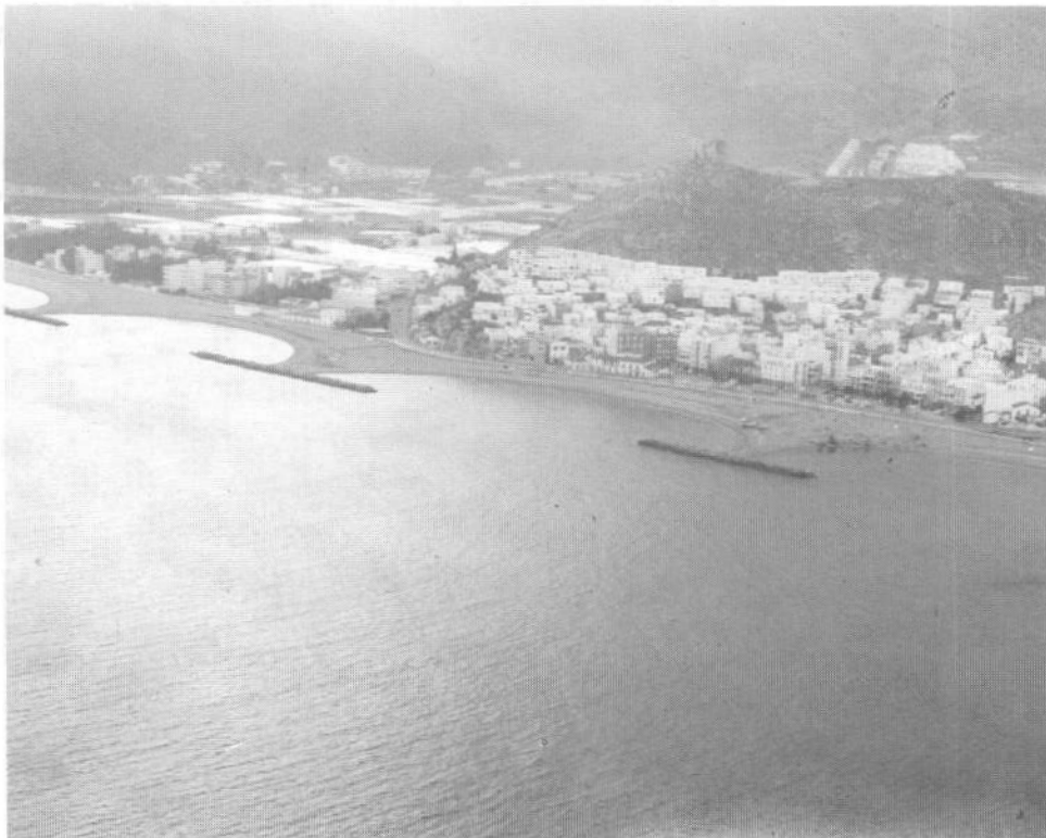
Defensas costeras paralelas a la línea de playa para evitar la erosión (Granada). Foto cedida por J. J. Durán
