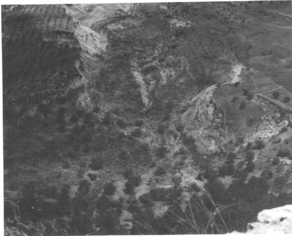
Vista parcial del deslizamiento de olivares de 1986 (Granada). Foto cedida J. J. Durán.
