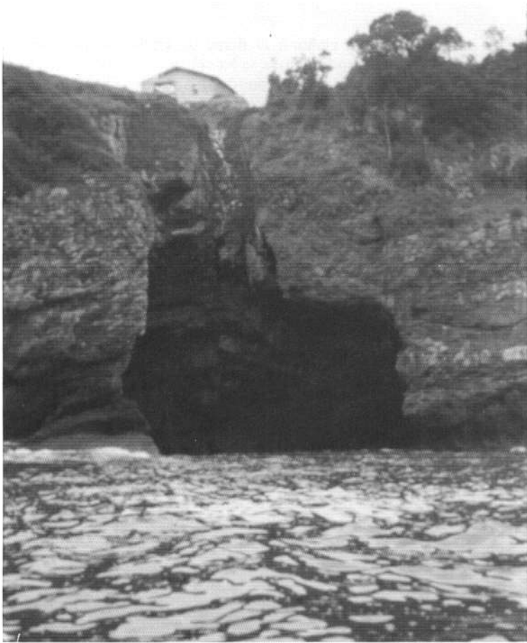
Hundimientos en la costa de Lekeitío (Vizcaya). Foto cedida por J. J. Durán.
